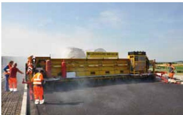
Комбинированный укладчик литого асфальта типа **EB 80-120 S**
